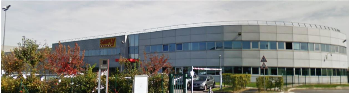
27 rue Helene Boucher Chilly-Mazarin 91380
