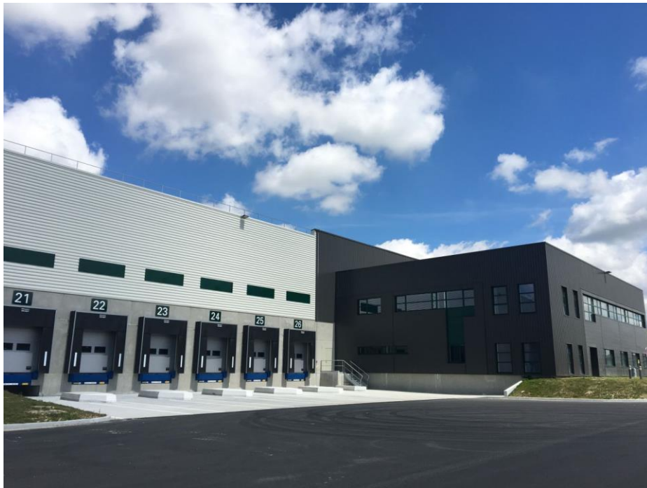
Entrée d'une zone de quai-stockage
